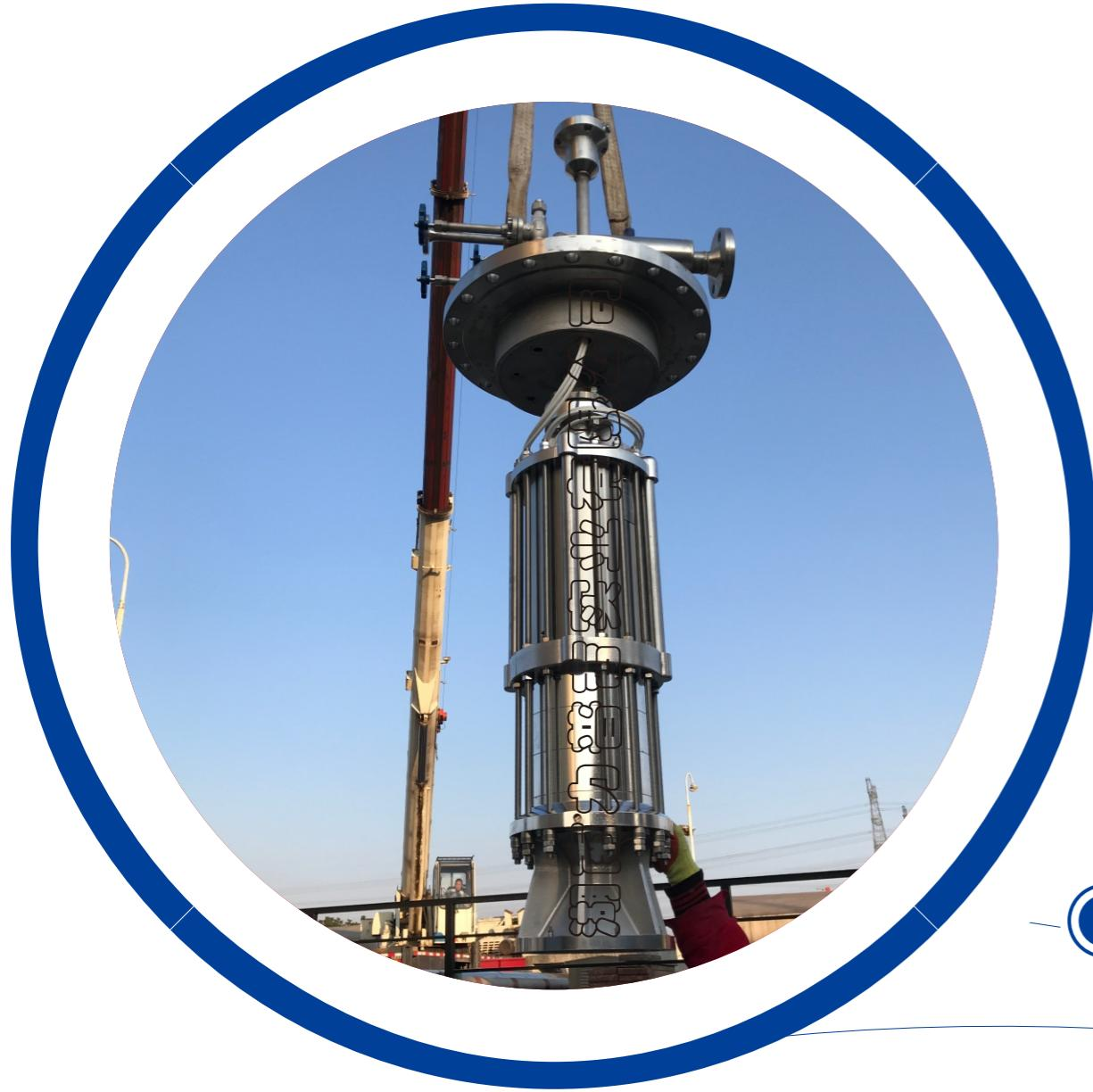
江阴天力燃气滨江气化站于2018年在原有的基础上增加两台潜液泵作为增压泵，用于城市燃气管网调峰。前端有四个LNG带压储罐，工作压力为0.2-0.5MPa，潜液泵出口压力1.5MPa，设计流量30m<sup>3</sup>/h，气化量20,000Nm<sup>3</sup>/h。增压泵为罐外容器式潜液泵。
